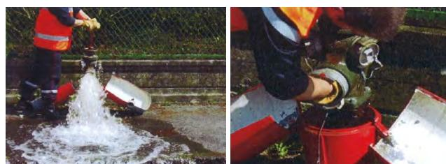
**5.** Installer l'appareil de mesure directement sur le PI/BI en respectant le sens de passage de l'eau, en maintenant la vanne de l'appareil de mesure partiellement ouverte
