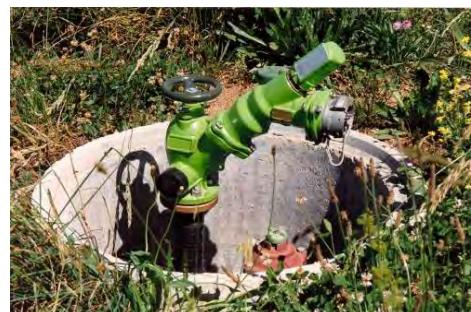
**Les PENA** qui ne seraient pas équipés d'un poteau d'aspiration bleu mais dotés d'un autre dispositif fixe d'aspiration (canne, guichet, ...) devront recevoir, au niveau de la prise, une **couleur bleue** (référence RAL 5015) permettant le repérage rapide de cette dernière.
