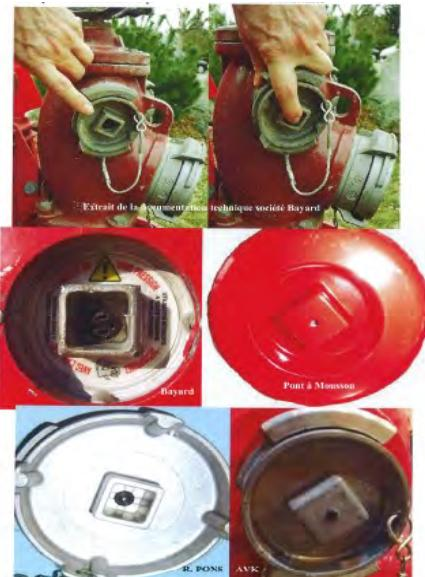
Dans la mesure du possible, ne pas se positionner au dessus de l'organe de manœuvre ni face aux raccords de refoulement :
